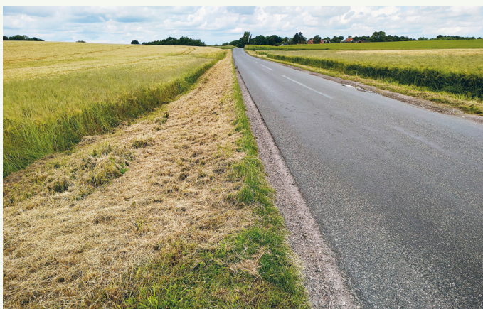
Figur 3: Vejkant mejet ned i juni som et eksempel på manglende rettidig omhu. Foto: 13. juni 2024.
